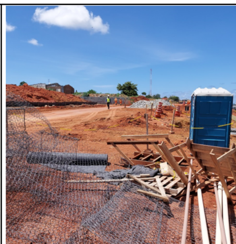
Foto 8 - Pátio de obras de estabilização no topo do talude: construção das drenagens e barreiras com gabiões.
