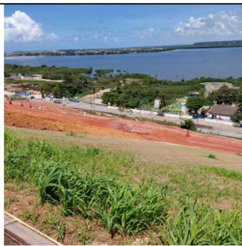
Foto 6 - Estabilização do talude da encosta. Início da hidrossemeadura.
