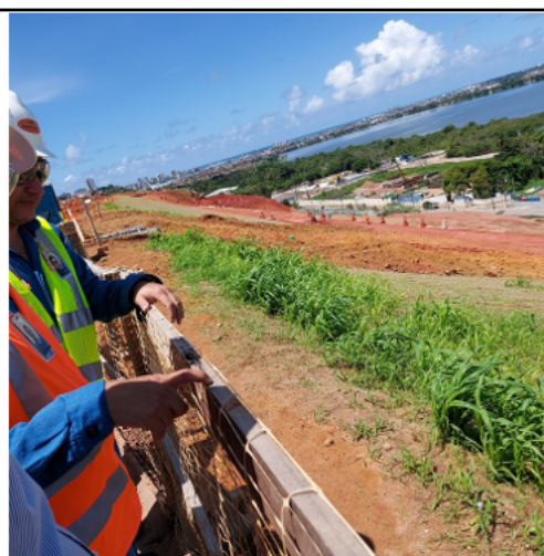
Foto 7 - Estabilização do talude da encosta. Início da hidrossemeadura.
