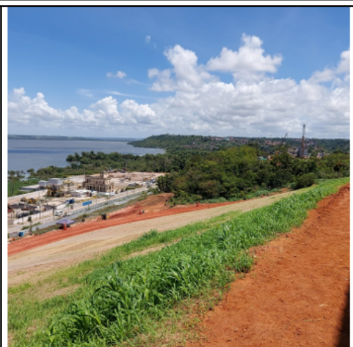
Foto 4 – Estabilização do talude da encosta. Início da hidrossemeadura.
